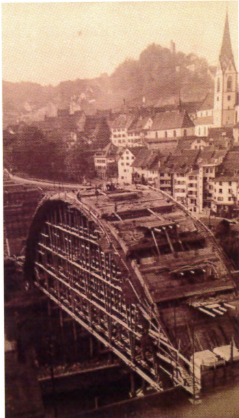
1926: Bau der Hochbrücke
