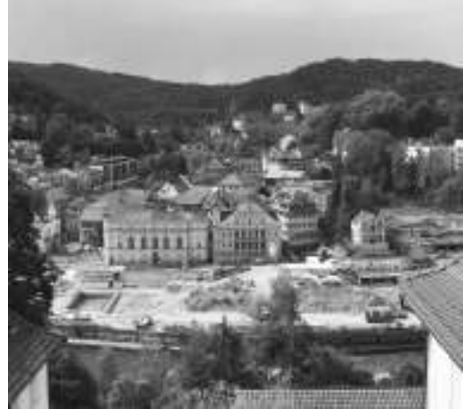
Aussicht auf die Baugrube für das Botta-Bad
